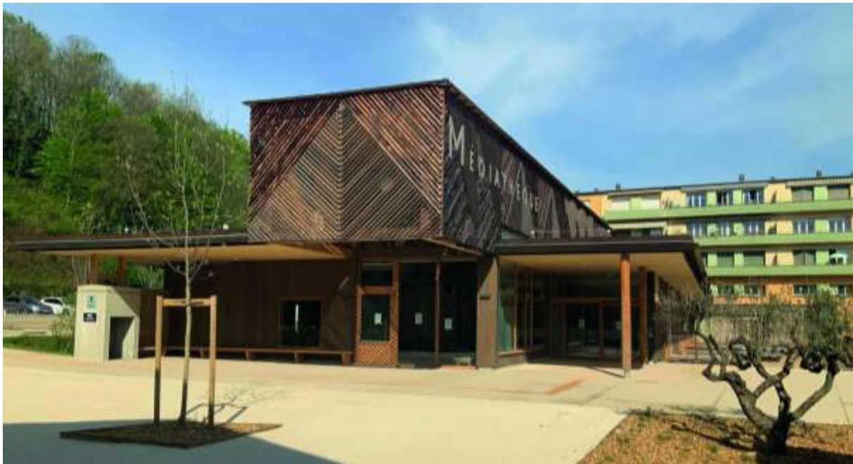
Figure 4 : Médiathèque tête de réseau des Vals du Dauphiné – © Atelier 43
